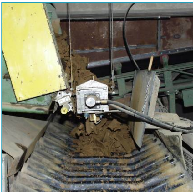
Feuchtemessung für den Freifall
