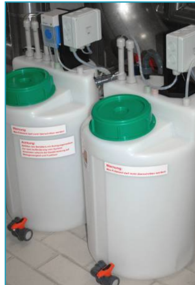
Behälterstationen für Reinigungsmedium
