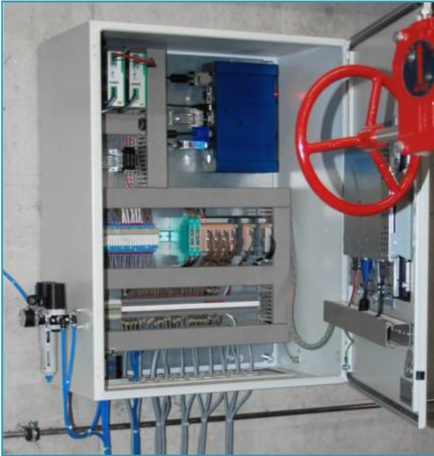
Schaltschrank mit PC und Touchscreen
