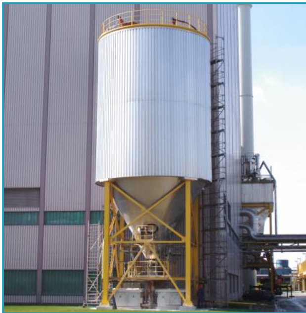
Silo mit vier Wägesensoren
