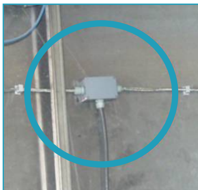
Eingepresster Wägesensor mit Schutzgehäuse am Stehzargensilo.
