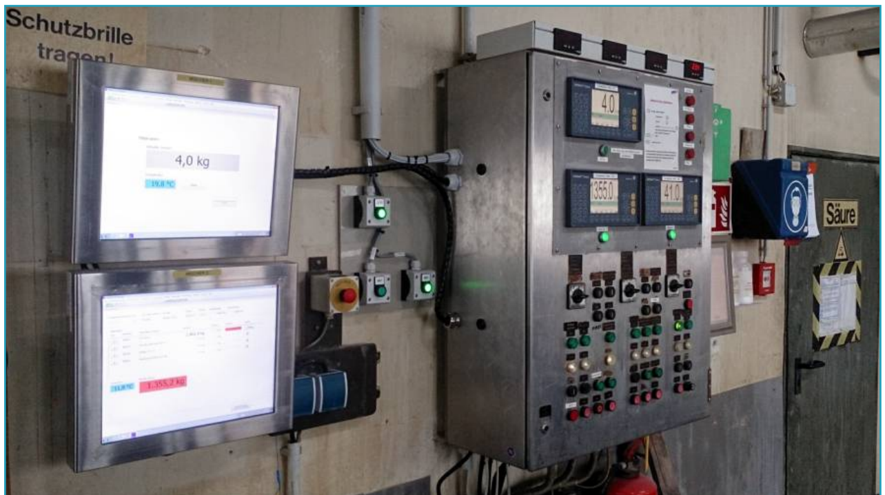
Beispiel: Bedien-, Steuer- und Regelement mit Sollwertvorgabe
